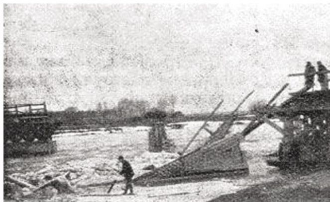
Ulanów nad Sanem. Most na Sanie po zerwaniu.
