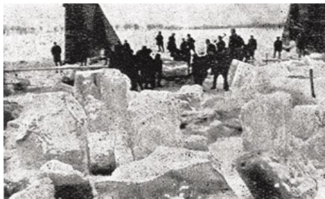
Ulanów nad Sanem. Uwalnianie mostu od lodu
