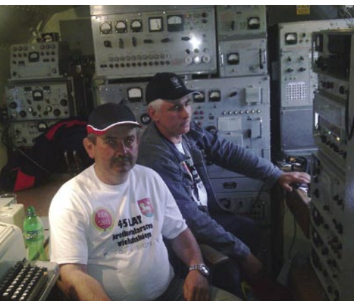
„SQ9OUA oraz SQ6IUF w pomieszczeniu radiostacji R-140” foto SP2JMR
